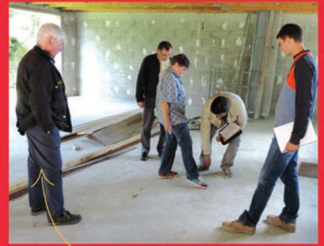
Réunion de chantier le 1er septembre
