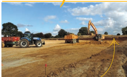
Terrassement le 2 septembre dernier
