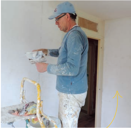
Début des travaux de peinture en mai
