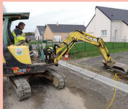
Réalisation d'un trottoir, 6 novembre 2014
