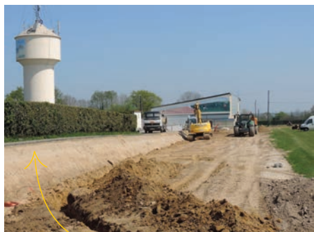
Travaux de terrassement, 21 avril 2015
