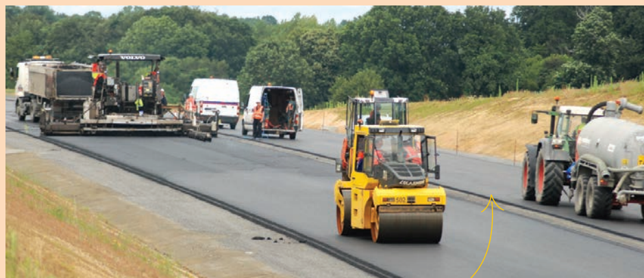
Pose de l'enrobé en juillet dernier
