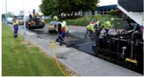
Réalisation d'un plateau surélevé, en mai dernier
