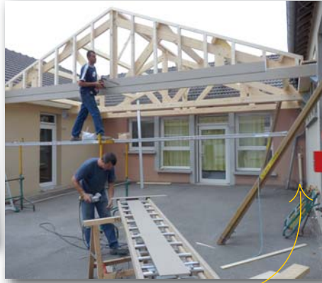
Juillet 2010 - Construction du préau de l'école Blanche Maupas
